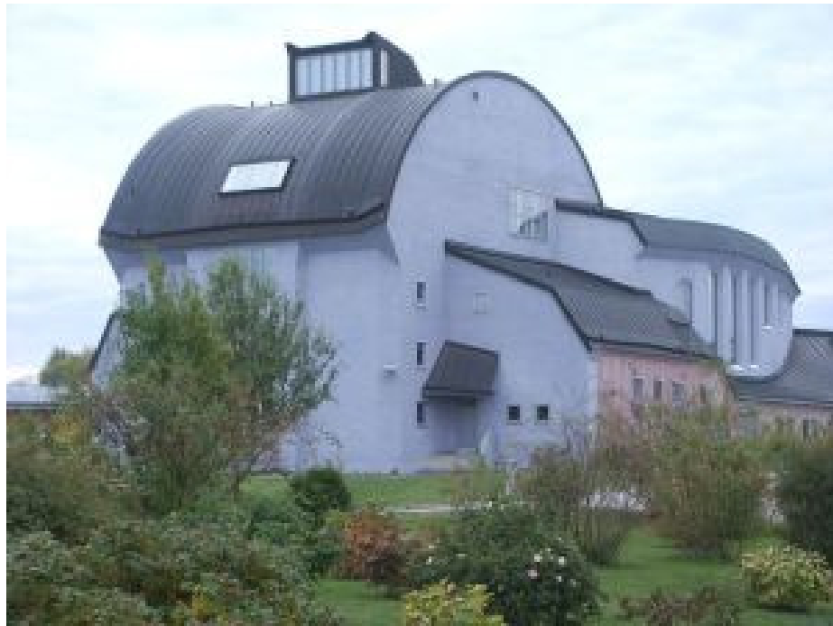
18. ábra: Transzperszonális alapokon épült kultúrház Ytterjånban 35
